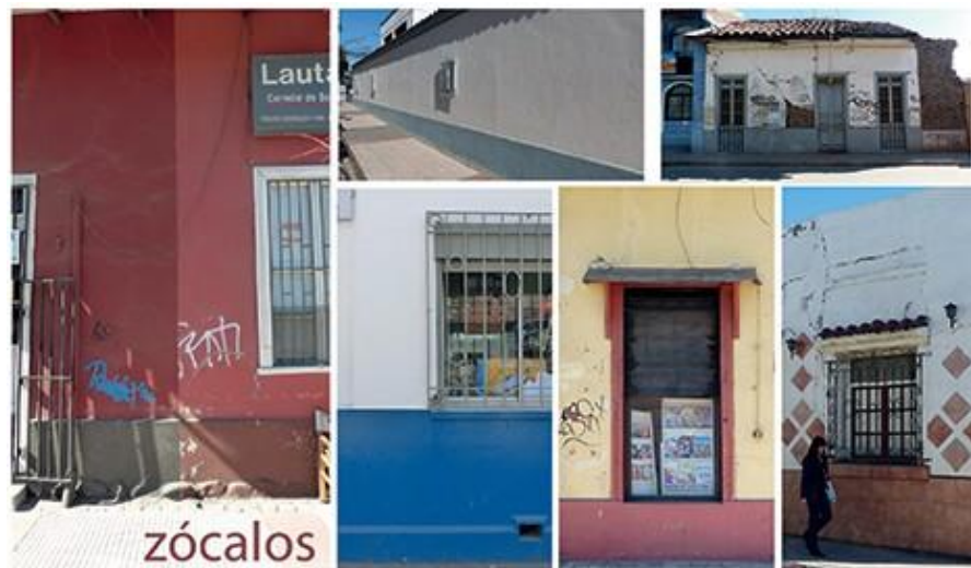
Figura 14. Zócalos destacados de la fachada a través de una diferencia de color o materialidad, que es contrastada, 2013 (fuente: el autor)
