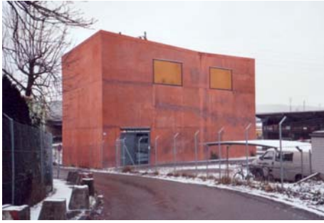
Fig. 6 Stellwerk Vorbahnhof Zürich.
